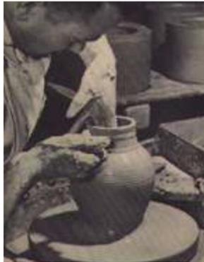
Gambar 24. Membentuk dengan alat putar mesin dengan tenaga listrik
